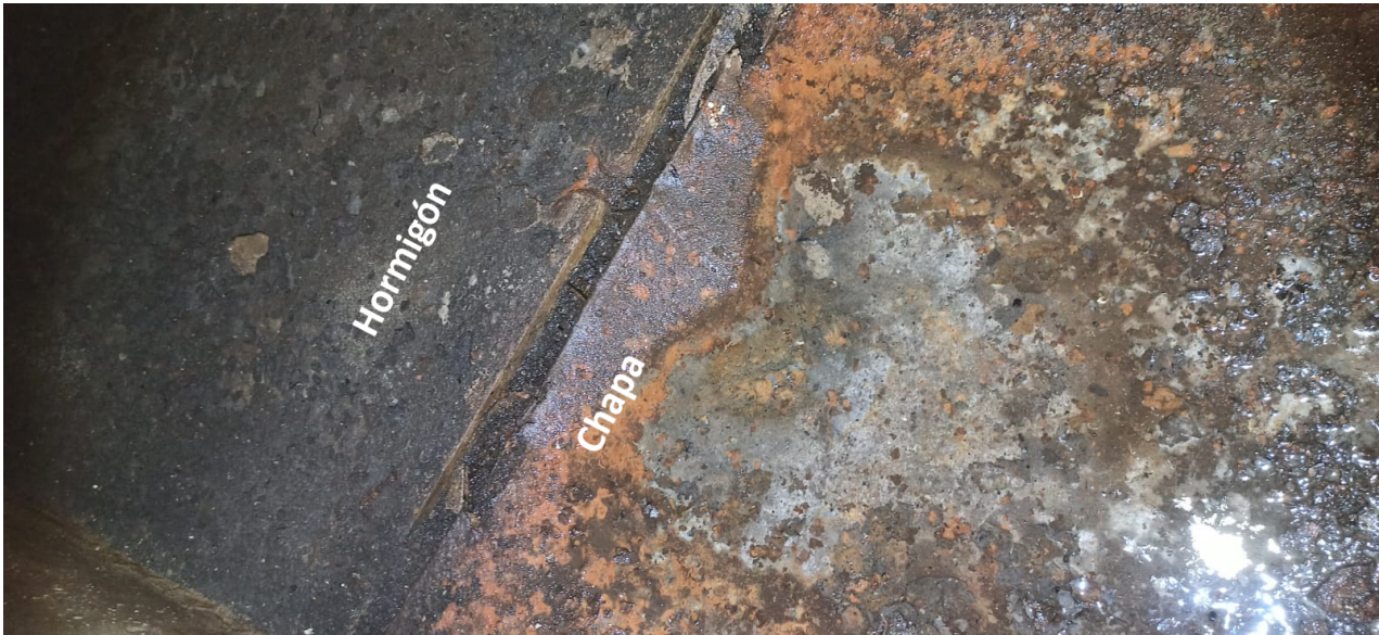
Ducteria retorno en sala de ventilación
