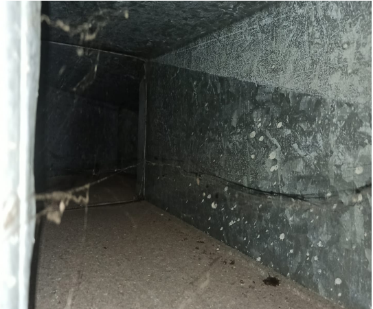
Interior de ducto inyección
